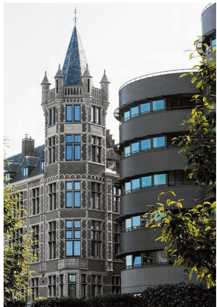
Antwerpens alte und neue Bauten.
