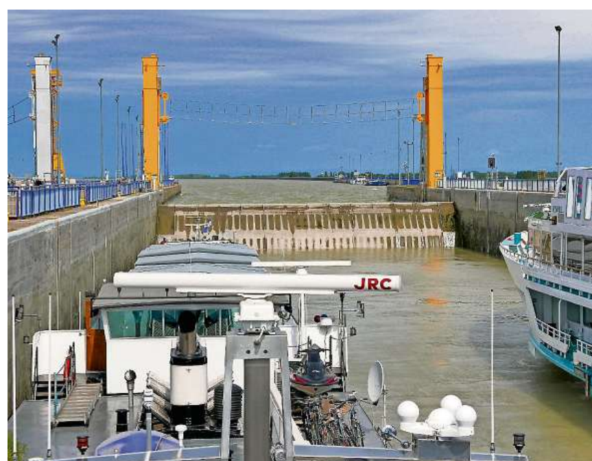
Die Schleuse von Gabčíkovo. 30 Meter Höhenunterschied in wenigen Minuten.
